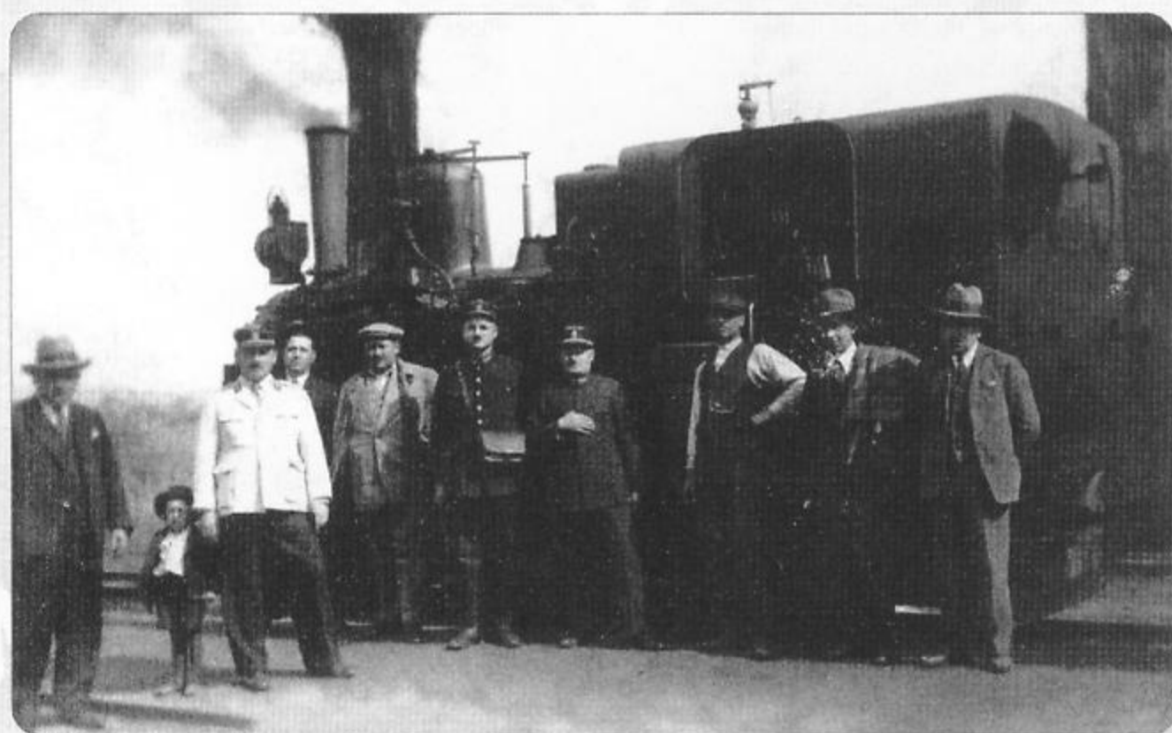
Construcția căii ferate și atelierele de reparat vagoane
