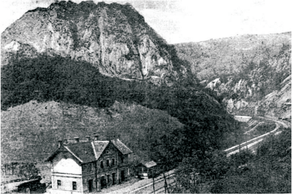
Gara și porțiune din traseul de cale ferată la Peștera Boli
