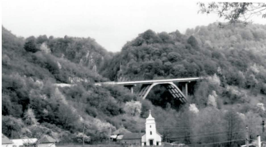
Crivadia astazi: - drum si viaduct peste apele Crivadiei si ruinele cetatii
