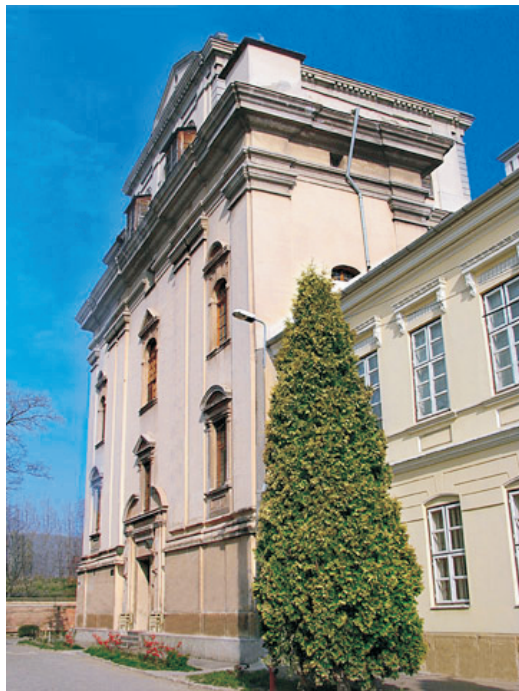
Clădirea în stil baroc a Bibliotecii Batthyaneum
