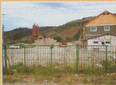
Stația de sortare S.C.F.D.P. Bara-Mare Concrete Sorting Station
