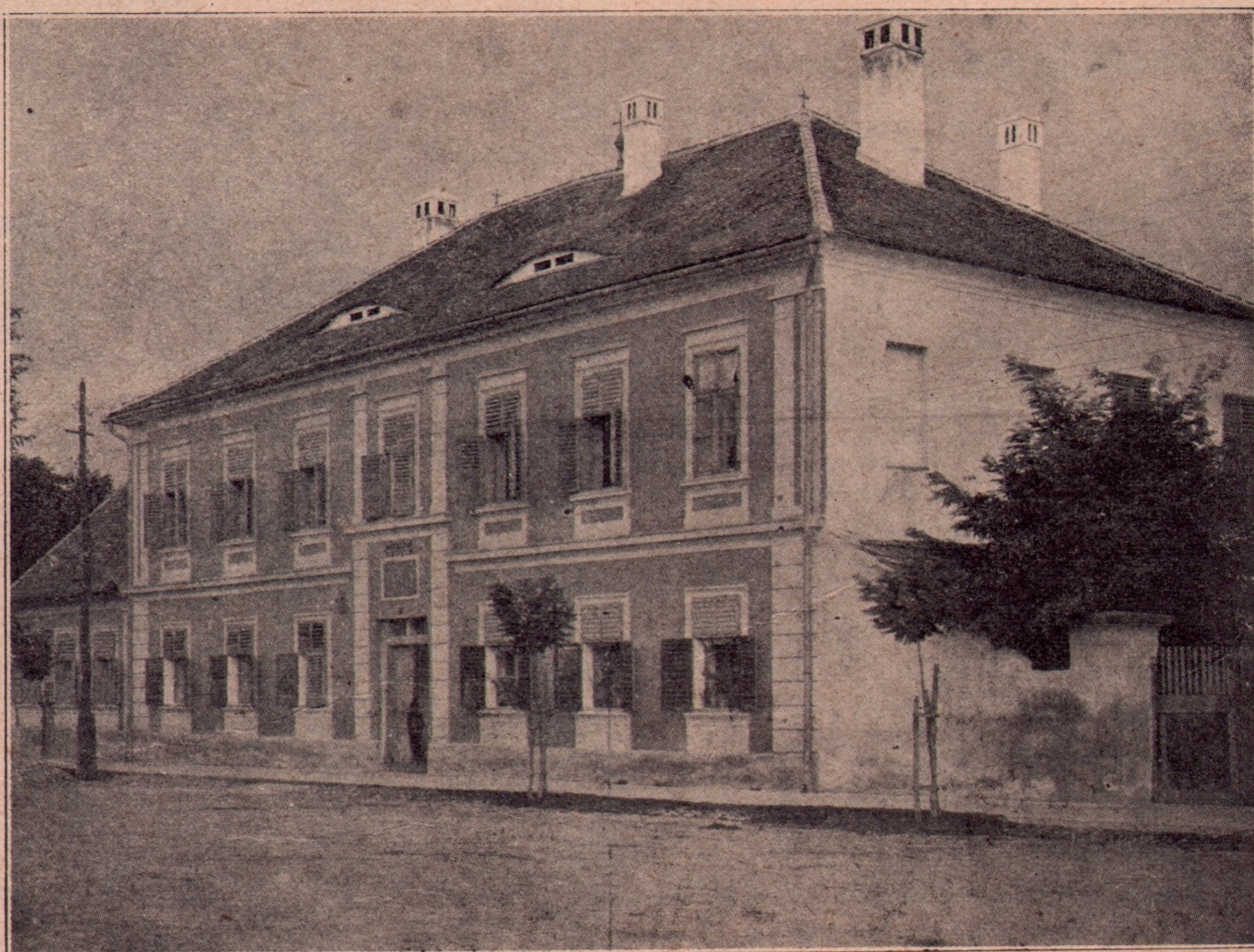
Școala gr.-or. românească, care are trei învățători și o învățătoare. Se susține fără ajutor de stat din puteri proprii și subvenționată de institutul de credit „ Ardeleana “. S'a zidit în 1884 și înainte de a fi ridicată, școala se țineă într'o casă foarte modestă, care există și azi și servește de locuință servitorului școlii.
