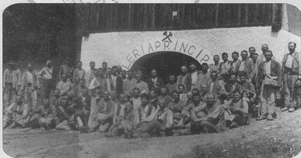
Galeria principală de la mina Crăciunești
