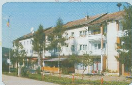
Blocul din centrul Băiței
