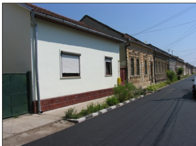
Casa de pe strada Teilor (renovata)
