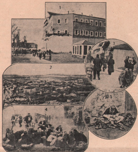
Vedeti din Durazzo, capitala Albaniei: Chipul de sus (Nr. 1) arată fosta Casarmă, o casă mare, care a fost prefăcută acum în reședință pentru noul Domnitor. Chipul da aci ni-o arată când era încă în reparare, cu bărnele scoase prin ferestre pentru sprijinirea schelelor. Nr. 2: Vederea peste tot a orașului, privit de pe puntea unui vapor; 3: O stradă cu mai mulți trecători; 4: Grup de Malisori; 5: Un cărpaciu așezat la un colț de stradă și primind reparaturi de încălzăminte.
