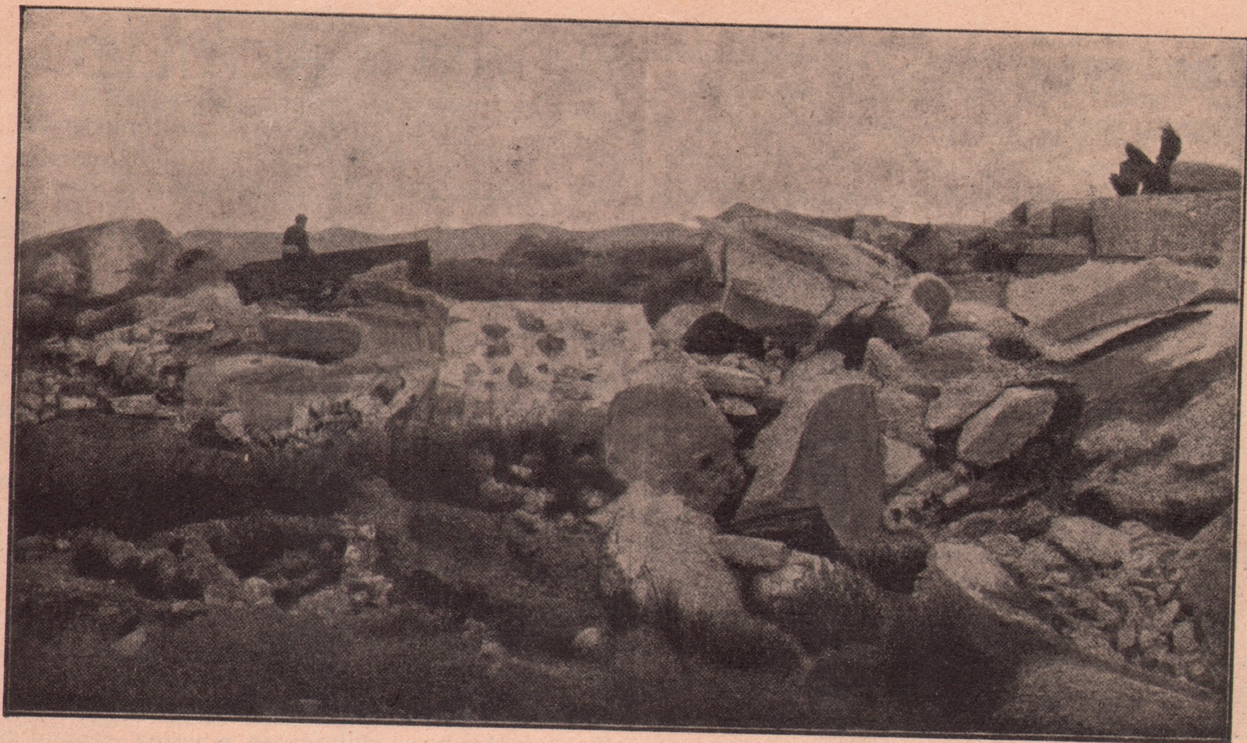
Vedere din Port-Arthur: Urme de gloanțe de tun rămase pe zidurile cetății.
