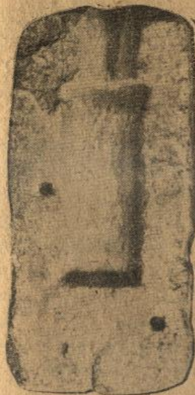
Pl. II. 1—2 Tipare de Toporașe de bronz (colecția autorului) 3, lipar de ciocan. Mărime \frac{1}{2} . 4, felul cum să așeze dopul de lemn 1, pentru a rămâne loc gol la turnare. 2, arată pe unde se turna bronzul.
